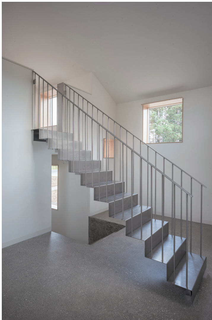
L'ESCALIER MÉTALLIQUE POUR ACCÉDER À LA MEZZANINE | TREPPE AUS METALL ZUM MEZZANINGESCHOSS
