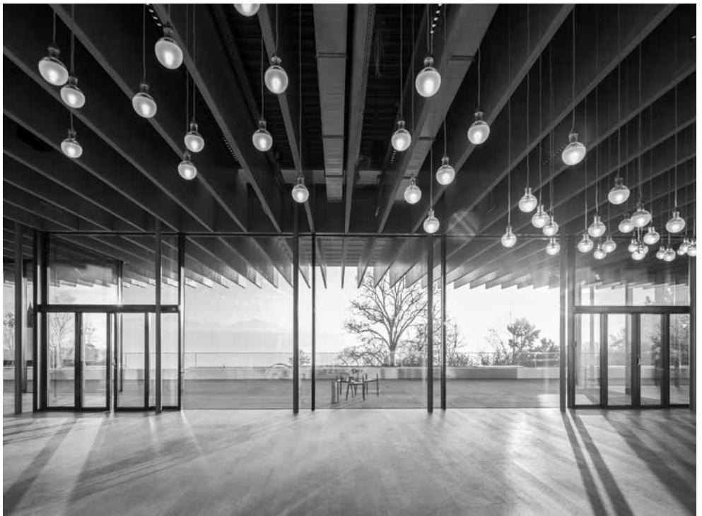
nordique de Sverre Fehn à la Biennale de Venise (1958-1962). Celle-ci consiste en un solivage de lames précontraintes de béton fibré à ultra haute performance (BFUHP), de 100 x 8 cm, surmonté d'une grille de poutrelles entre lesquelles sont ménagées des fentes laissant la lumière pénétrer profondément. Des colonnes d'acier reprennent ponctuellement les charges. Cette adjonction, qui littéralement termine l'édi-
